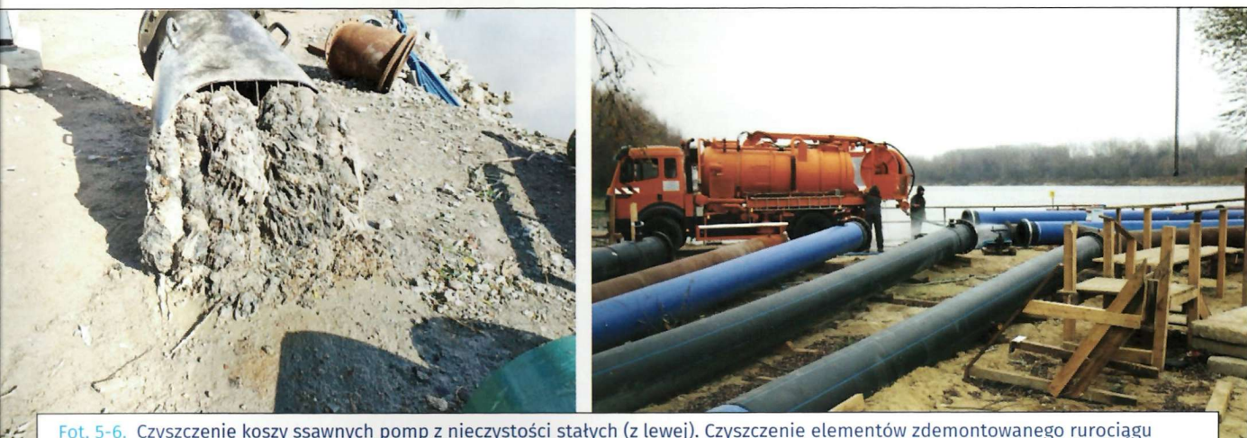
Fot. 5-6. Czyszczenie koszy ssawnych pomp z nieczystości stałych (z lewej). Czyszczenie elementów zdemontowanego rurociągu (z prawej)
