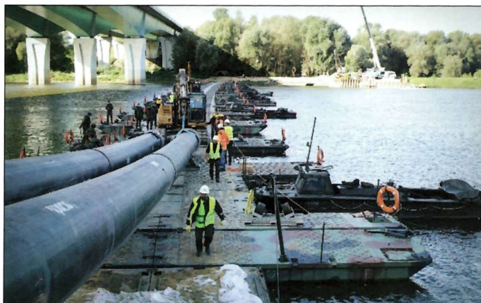
Fot. 3-4. Wciąganie obu nitek rurociągu zastępczego na konstrukcję nośną mostu pontonowego (z lewej). Funkcjonujący bypass na moście pontonowym. W tle widoczny basen czepni i stacja pomp (z prawej)
