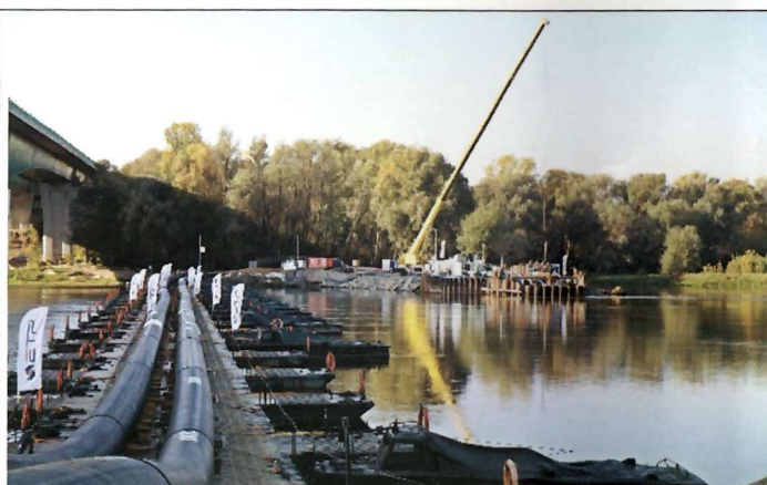
Fot. 3-4. Wciąganie obu nitek rurociągu zastępczego na konstrukcję nośną mostu pontonowego (z lewej). Funkcjonujący bypass na moście pontonowym. W tle widoczny basen czepni i stacja pomp (z prawej)
