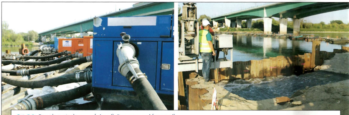
Fot. 7-8. Pracująca stacja pomp (z lewej). Basen czepni (z prawej)
